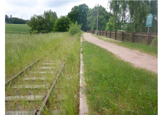
Foto 319: Kleinnaundorf: Radweg in ungebundener Bauweise auf Bahnsteig des ehemaligen Bhf Kleinnaundorf, Bahnkörper erhalten
