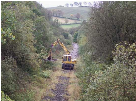
Foto 41: Entfernung von Gleisen und Schwellen „vor-Kopf“ (Foto: Kerpen, G. 2015)
