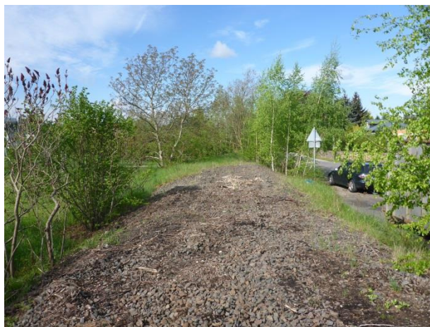
Foto 277: Leipzig, Lausaner Weg: Schotterkörper noch vorhanden und weitgehend frei von Vegetation
