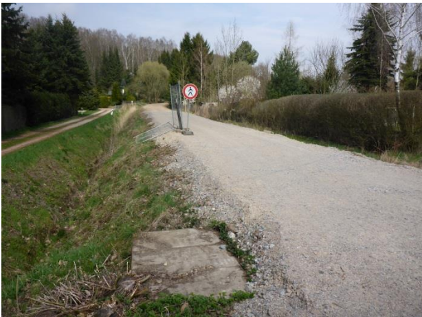
Foto 329: Chemnitz-Wittgensdorf: Chemnitztalradweg im Bau
