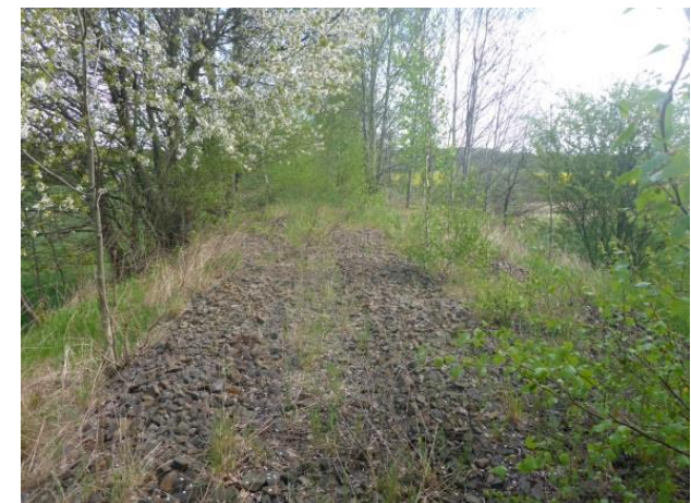
Foto 206: Wiesa: Schotter mit Birkenaufwuchs, Gleise und Schwellen nicht mehr vorhanden
