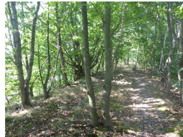
Foto 269: Theuma, Kemmlerblick: Dichter Gehölzaufwuchs an Böschungsbereichen des Bahndamms
