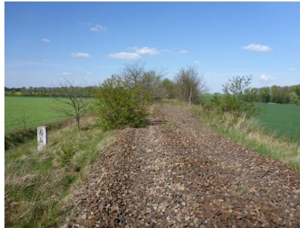
Foto 199: Kleinwelka: Schotterkörper ist stellenweise frei von Vegetation
