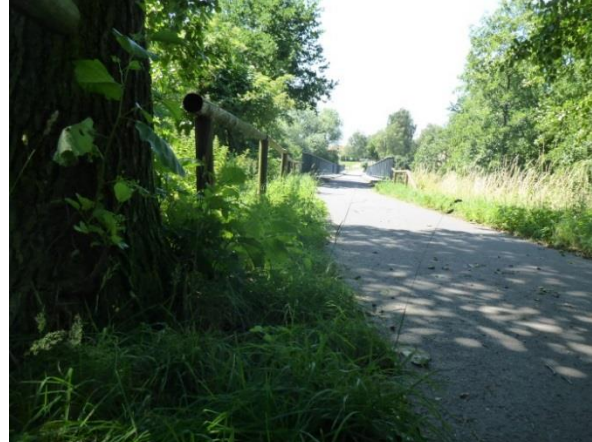
Foto 297: Porschendorf: Umgesetzter Radweg, im Hintergrund die Brücke über die Wesenitz
