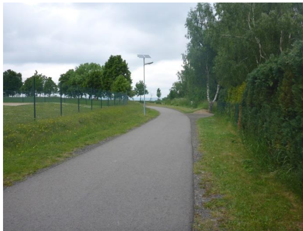
Foto 321: Bannewitz, Neues Leben: Radweg verläuft entlang eines Wohngebietes in Gleichlage
