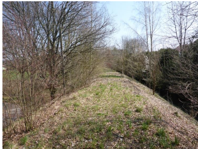
Foto 2: Bahnstrecke in Dammlage
