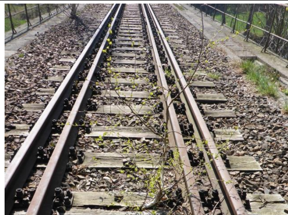
Foto 103: Bahnkörper inklusive Gleise und Holzschwellen mit vereinzelt Birkenaufwuchs
