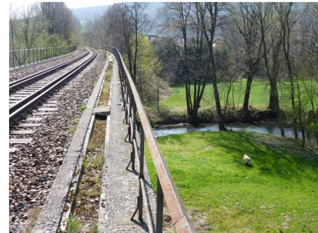
Foto 182: Obergurig: Überquerung der Hauptspree
