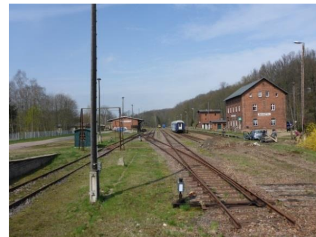
Foto 254: Markersdorf: Gleisanlagen am Bahnhof Markersdorf/Taura
