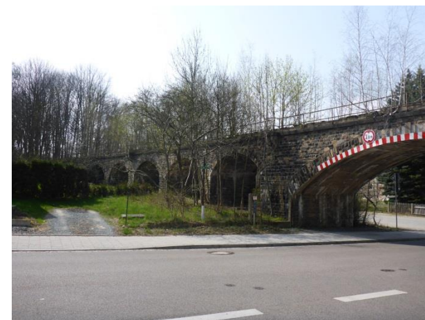
Foto 260: Chemnitz, Wittgensdorfer Straße: Viadukt
