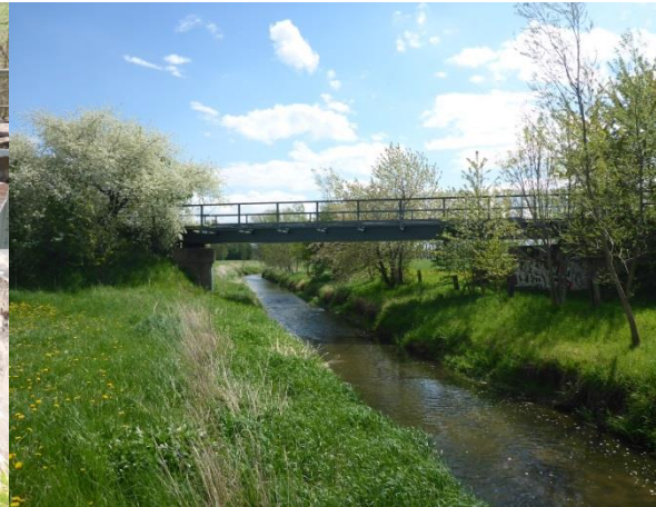
Foto 51: Widerlager der Brücke befinden sich außerhalb des Gewässers – kein bau- und anlagebedingter Eingriff in das Fließgewässer
