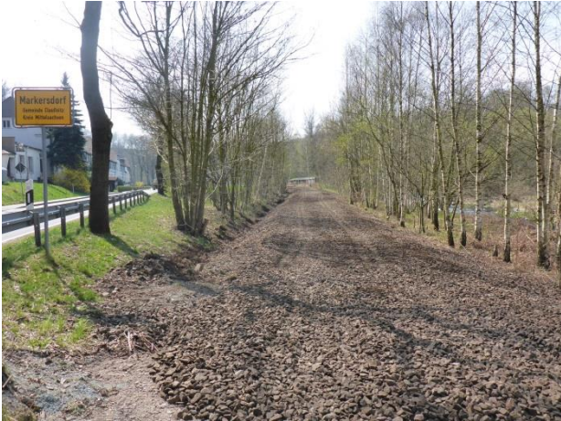
Foto 326: Markersdorf: Radweg im Bau, Schotterkörper bereits vorbereitet, seitlicher Gehölzaufwuchs kann verbleiben
