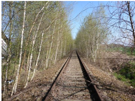
Foto 100: Bahnkörper inklusive Gleise und Schwellen ohne Vegetation
