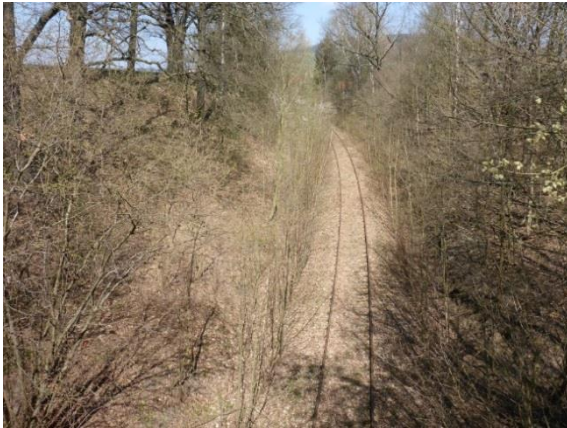
Foto 58: Bahnkörper in Einschnittlage – keine optische Störwirkung
