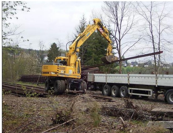
Foto 45: Flächenbeanspruchung im Zuge der Entfernung von Gleisen und Schwellen (Foto: Kerpen, G. 2015)
