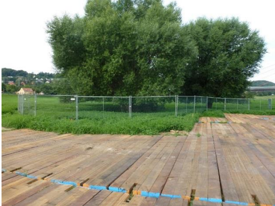
Foto 79: Vermeidung durch Baumschutz und Baggermatratzen
