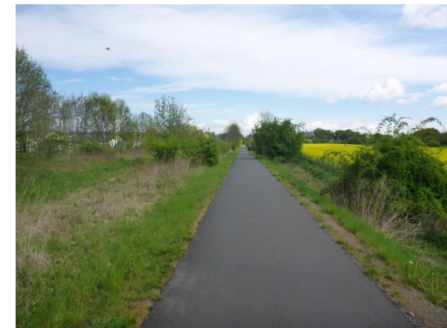
Foto 346: Seebenisch: Radweg in Asphaltbauweise verläuft durch Halboffenland
