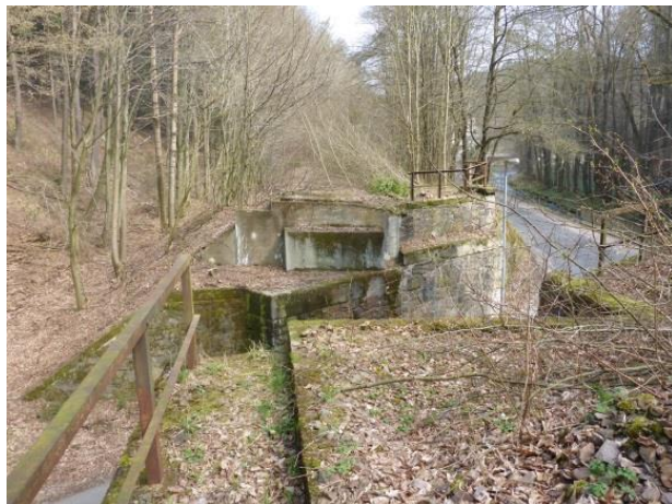
Foto 234: Berbersdorf: Abgetragenes Brückenbauwerk im Bereich der Berbersdorfer Straße
