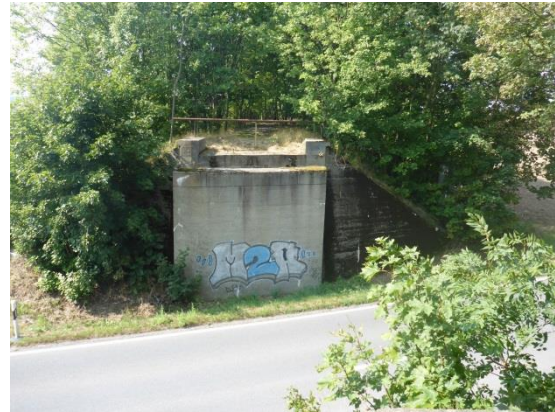
Foto 40: Ansicht des Bahndammes mit Gehölzen auf den Dammböschungen und der -krone
