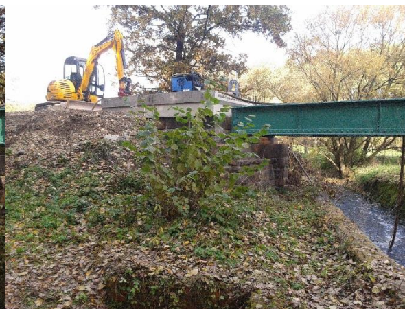
Foto 55: Bauandienung der Brücke ausschließlich Vorkopf – kein Eingriff in das Fließgewässer
