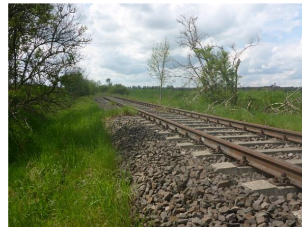
Foto 283: Strehla: Bahnkörper vollständig vorhanden und weitgehend vegetationsfrei westlich der B 182
