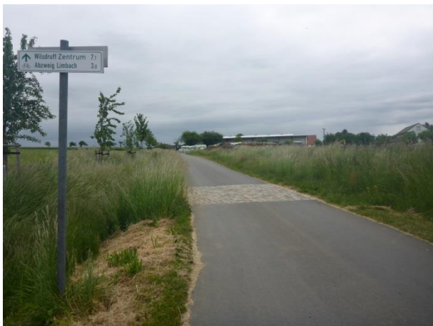
Foto 352: Wilsdruff, Helbigsdorfer Straße: In Asphaltbauweise umgesetzter Radweg auf ehemaliger Bahnstrecke in Offenland
