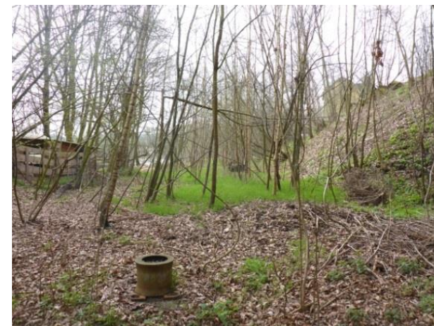
Foto 245: Göritzhein, Niedermühle: Schotterkörper und Schwellen unter dichter Krautschicht und Gehölzaufwuchs
