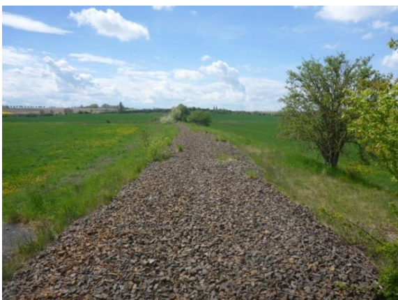
Foto 71: stillgelegte Bahntrasse in Gleichlage in topographisch nicht bewegtem Gelände und ohne sichtverschattende Gehölze
