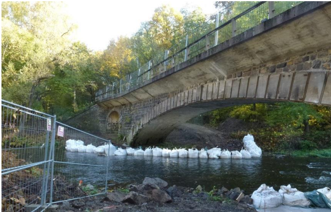
Foto 57: Fangedämme zur Vermeidung von Beeinträchtigungen des Fließgewässers durch Bautätigkeiten im Uferbereich
