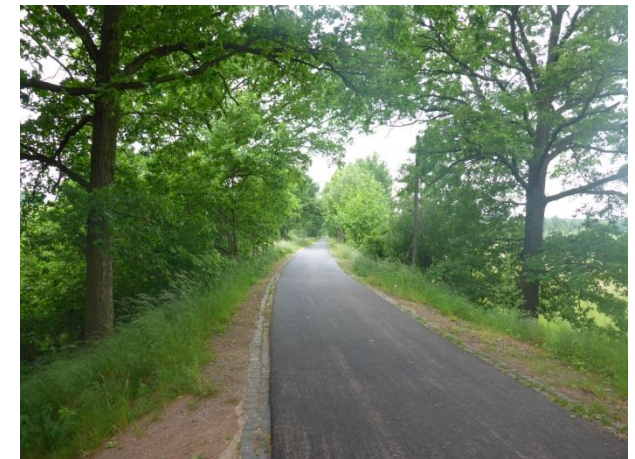
Foto 316: Kleinnaundorf: Asphaltierter Radweg in Dammlage
