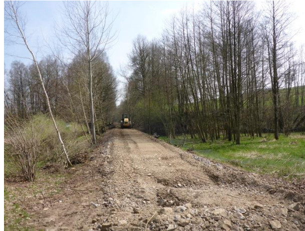
Foto 327: Markersdorf: Gleise und Schwellen wurden im Zuge des Radwegebaus bereits entfernt
