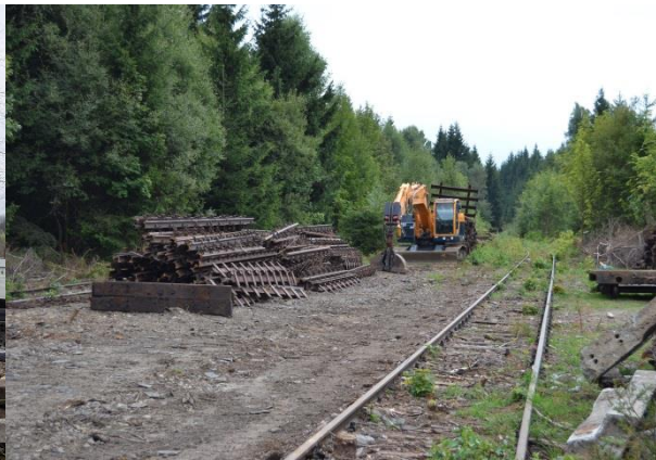
Foto 46: Flächenbeanspruchung im Zuge der Entfernung von Gleisen und Schwellen (Foto: Wikipedia-Beitrag zur Bahnstrecke Reitzenhain-Flöha)
