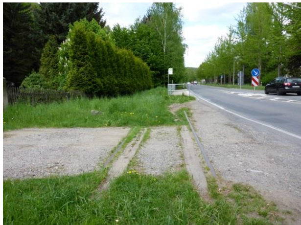
Foto 222: Pirna, Rottwerndorfer Straße: Gleise noch vorhanden im Bereich einer Grundstückszufahrt
