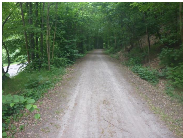
Foto 356: Wilsdruff, Herzogswalder Straße: Radweg in Hanglage, in ungebundener Bauweise
