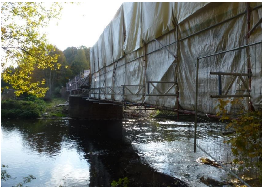
Foto 56: bauzeitlich eingehauste Brücke über das Fließgewässer während der Sanierung zur Vermeidung von Beeinträchtigungen
