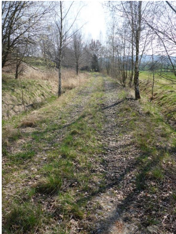
Foto 210: Rodewitz: vorhandener Schotter mit Gras-/Krautschicht kurz nach dem Abzweig von 6216 Bautzen – Wilthen
