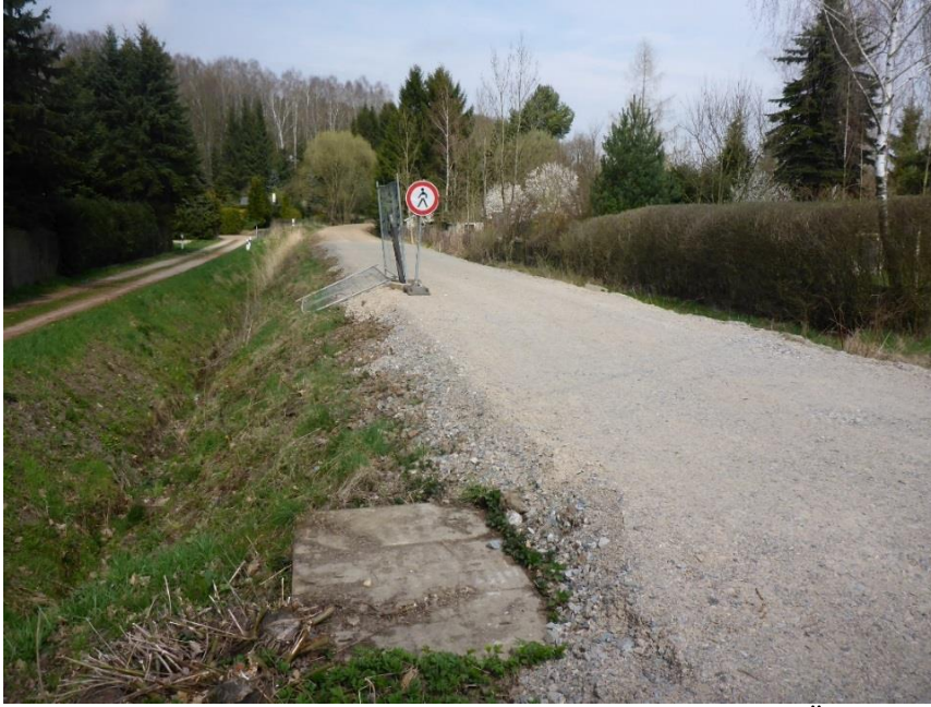
Foto 89: Eingriff nur in den oberen Bereich des Schotterkörpers - GÜNSTIG
