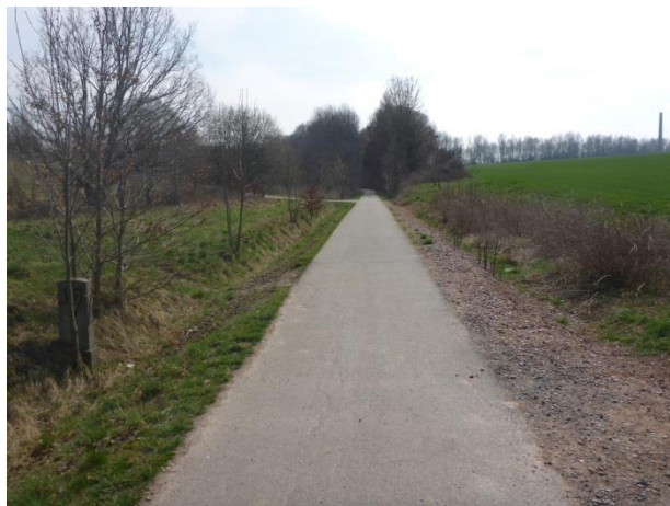
Foto 323: Hainichen: Umgesetzter Radweg in leichter Dammlage
