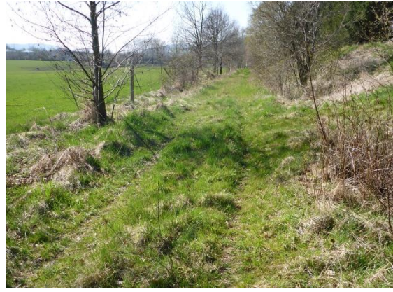
Foto 117: Schotterkörper mit flächendeckender Ruderaler Grasflur
