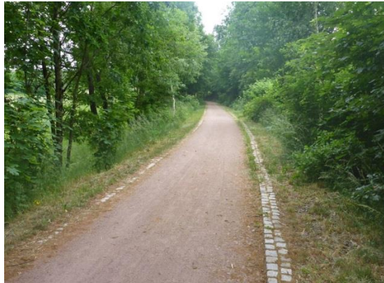
Foto 94: Beispiel für Radwege auf nachgenutzter Bahntrasse mit wassergebundener Decke
