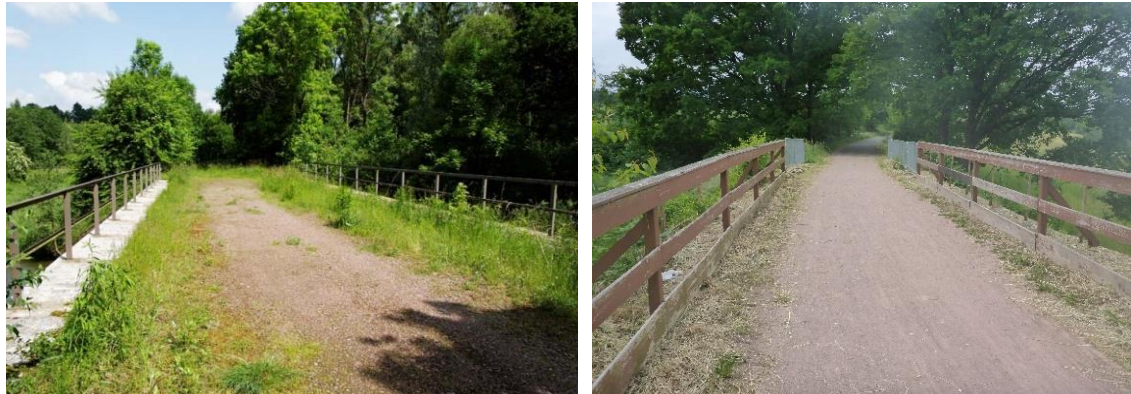
Foto 171: überführte Saumstrukturen als Verbundelemente mit wassergebundener Decke für Reptilien
