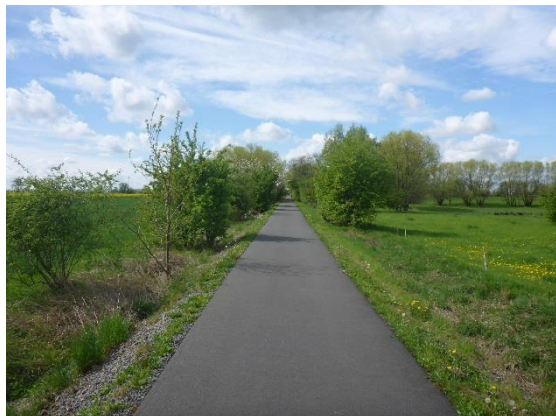
Foto 77: nach dem Bau – Erhalt der vorhandenen Gehölze weiterhin gegeben
