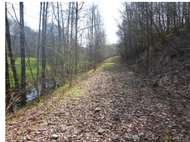
Foto 239: Neutaubenhain: Bahnkörper in Anschnittlage mit geringer Krautschicht im Tal des Aubaches
