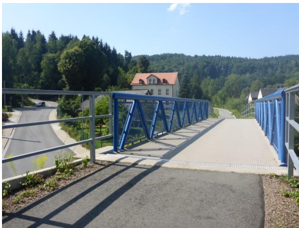
Foto 333: Aue, Brückenstraße: Neu errichtetes Brückenbauwerk über eine Straße
