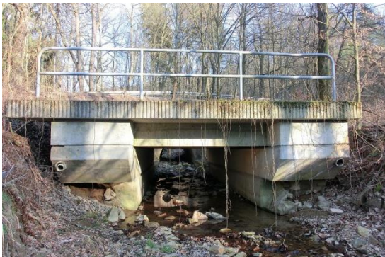
Foto 146: Stahlbetonbrücke über Fließgewässer mit Querfuge, vgl. Foto 148 mit Hangplätzen, vgl. Foto 147 (Foto: C. Schmidt)
