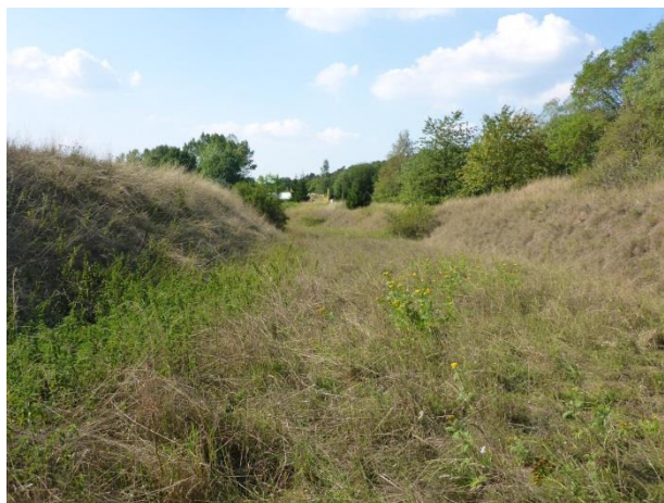
Foto 271: Neuensalz: Bahnstrecke im Offenland, in Einschnittlage
