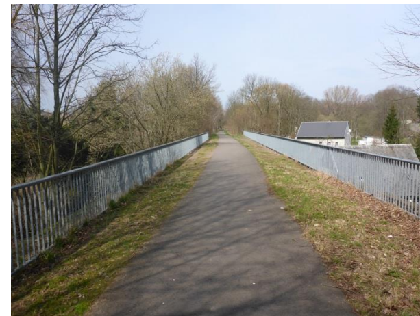
Foto 325: Hainichen: Radweg in Dammlage in der OL Hainichen
