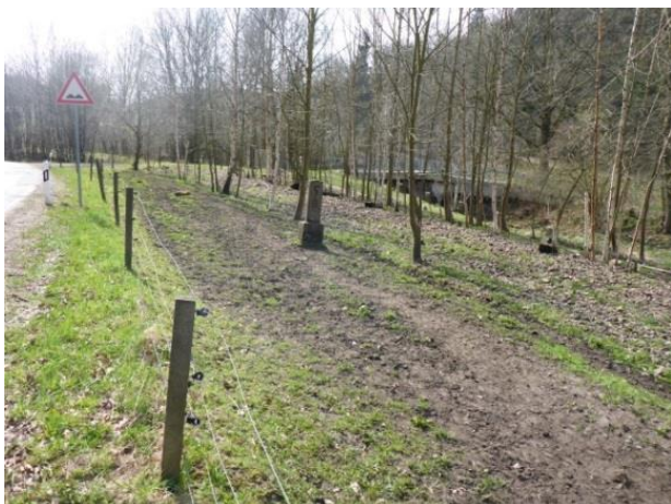
Foto 252: Stein: Nutzung als Wirtschaftsweg, Schotter, Schwellen und Gleise sind vollständig entfernt
