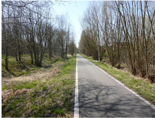
Foto 294: Köblitz: Umgesetzter Radweg in leichter Dammlage mit begleitenden Gehölzen
