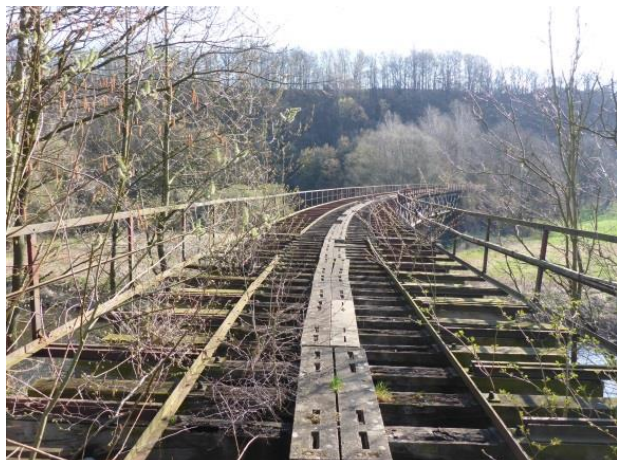
Foto 237: Rochlitz: Brückenbauwerk über die Zwickauer Mulde bei Rochlitz
