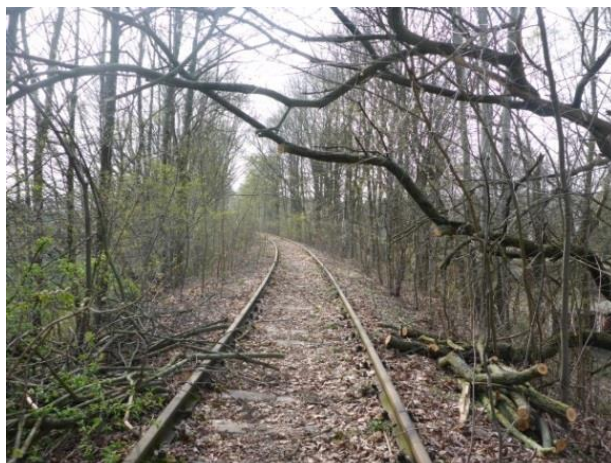
Foto 265: Chemnitz: Pflegemaßnahmen im Bereich Kopernikusstraße
