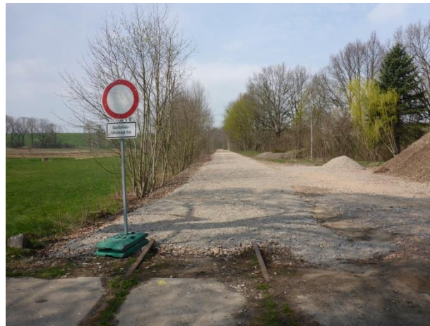
Foto 330: Chemnitz-Glösa: Radweg im Bau auf ehemaliger Bahnstrecke
