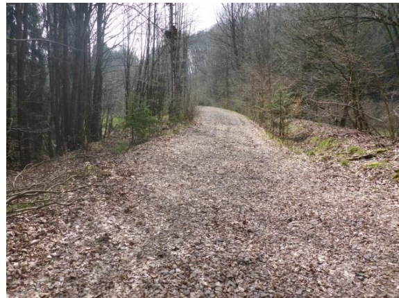
Foto 14: Im Jahr 1998 stillgelegte Strecke
