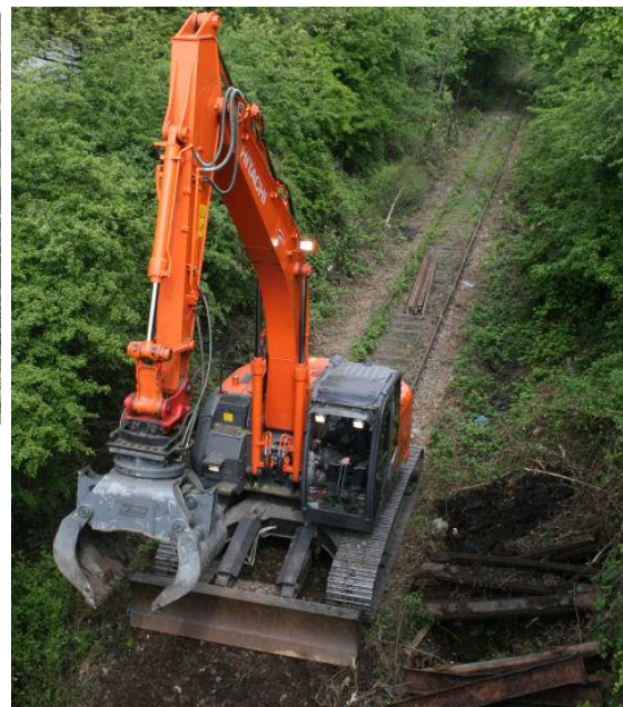
Foto 44: Entfernung von Gleisen und Schwellen, Beeinträchtigung der Vegetation seitlich der Bahntrasse durch temporäre Ablagerung entfernter Gleise/Schwellen (Foto: http://www.velberteransichten.de/bahnueckbau.htm )
