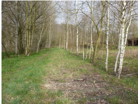
Foto 116: Bahnkörper mit Schotter und Betonschwellen mit lückiger Ruderaler Grasflur
