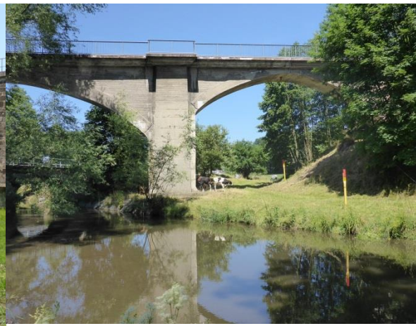
Foto 53: Umgesetzter Radweg verläuft über sanierte Brücke – kein Eingriff in das Fließgewässer
