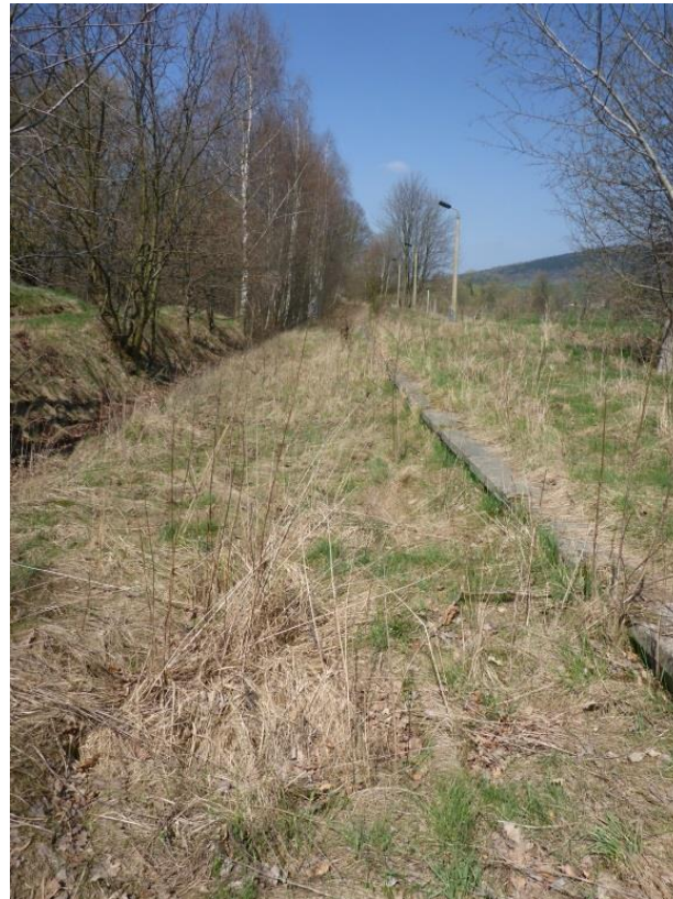
Foto 211: Rodewitz: ehem. Bahnsteig mit Beleuchtung, Bahnkörper vollständig mit Gras-/Hochstaudenflur abgedeckt
