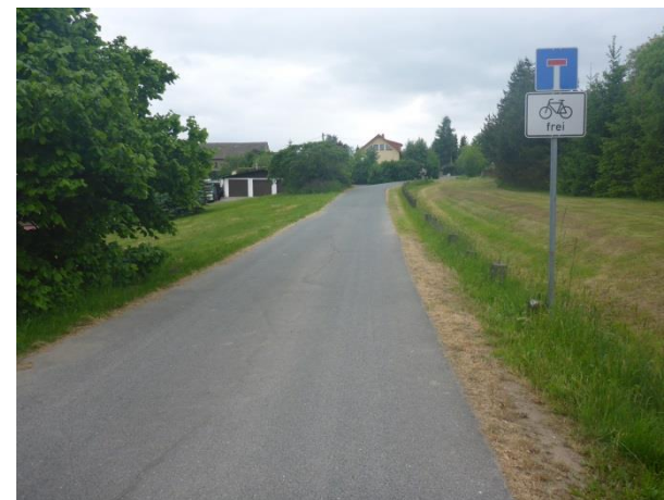
Foto 357: Reinsberg, Hauptstraße: Radweg in Asphaltbauweise umgesetzt
