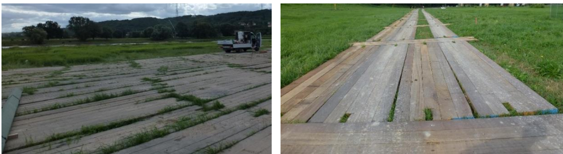
Foto 47: Vermeidung von Bodenverdichtungen durch Baggermatratzen
