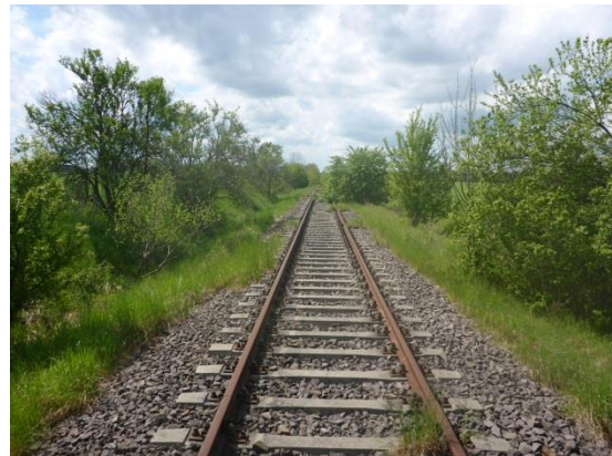
Foto 101: Bahnkörper inklusive Gleise und Schwellen ohne Vegetation
