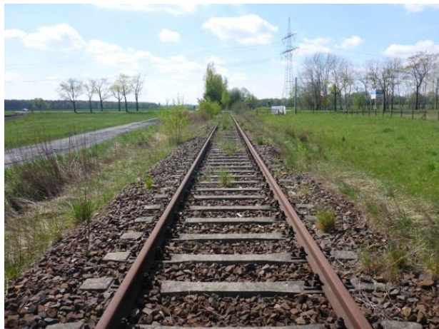
Foto 189: Wartha: Bahnkörper mit geringer Krautschicht und vereinzeltem Gehölzaufwuchs (nördlich der Querung mit der B 96)
