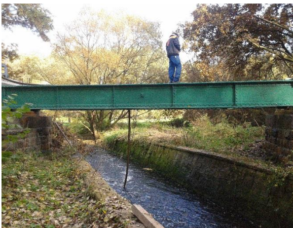
Foto 54: neuer Oberbau auf bestehenden Widerlagern – kein Eingriff in das Fließgewässer erforderlich
