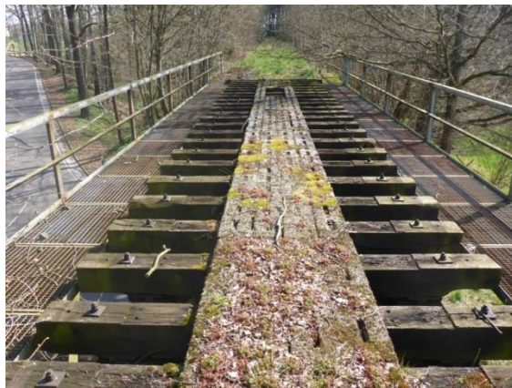
Foto 19: Flechten und Moose auf aufgelassener Brücke im Zuge einer ehemaligen Bahntrasse (Strecke 1998 stillgelegt)
