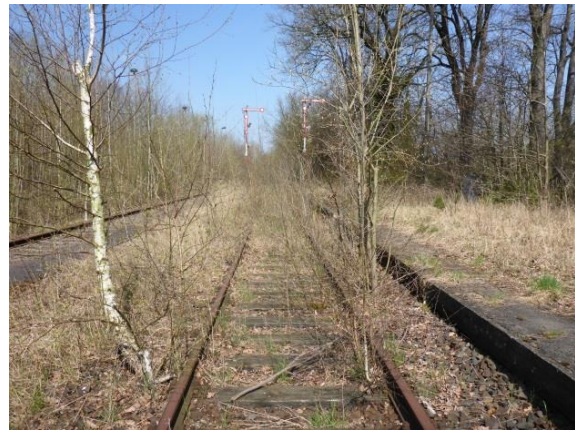
Foto 6: Bahnkörper vollständig vorhanden, wird nicht betriebsfähig unterhalten (Strecke 2004 stillgelegt)
