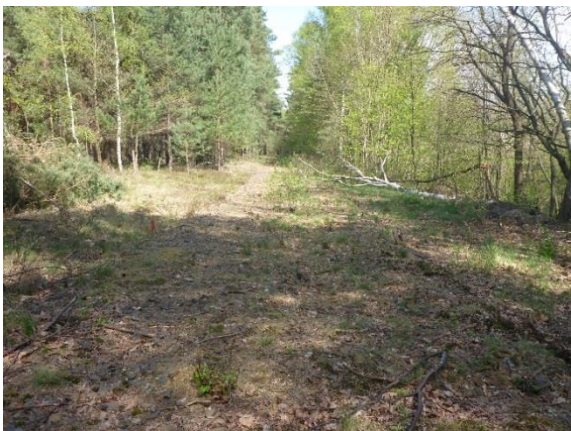
Foto 65: Bahnkörper in geschlossenen Waldbeständen – ein Radweg wäre nicht einsehbar
