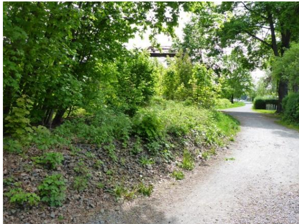
Foto 219: Pirna, Walkmühlenweg: Ehemaliger Bahndamm, dahinter die Brücke über die Gottleuba
