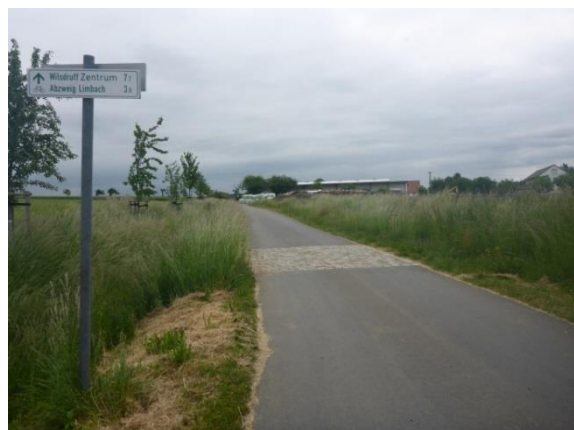
Foto 72: Radweg auf ehemaliger Bahnstrecke in Gleichlage, ohne sichtverschattende Gehölze
