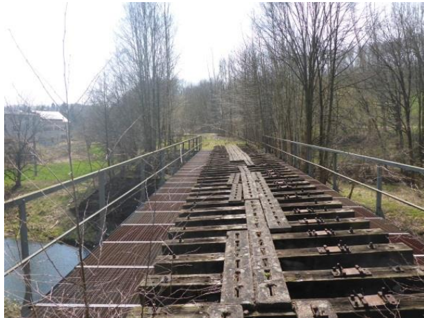
Foto 231: Niederstriegis: Brücke über die Striegis südwestlich von Niederstriegis
