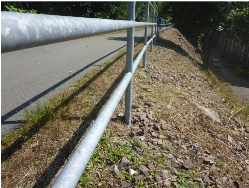
Foto 90: Radweg mit erhaltenem Gleisschotter unmittelbar neben der Fahrbahndecke - GÜNSTIG
