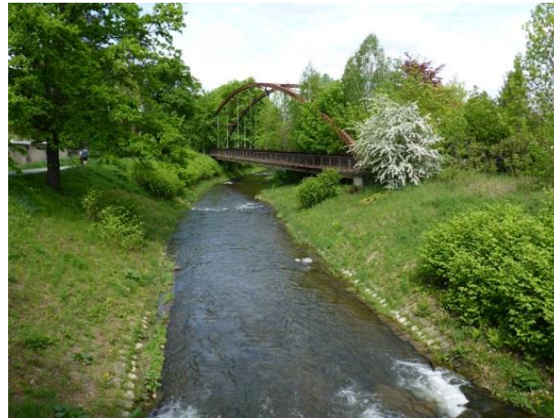
Foto 220: Pirna, Walkmühlenweg: Eisenbahnbrücke über die Gottleuba
