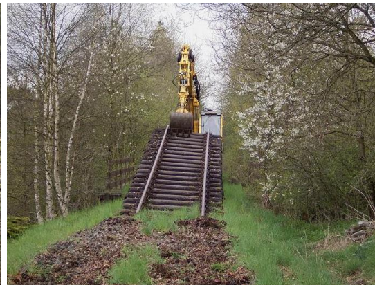
Foto 42: Entfernung von Gleisen und Schwellen (Foto: Kerpen, G. 2015)
