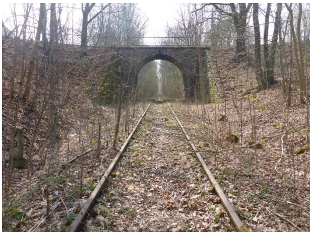
Foto 261: Chemnitz: Überführung der Limbacher Straße
