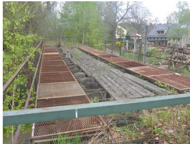
Foto 202: Kamenz: Brücke über Hennersdorfer Weg, Gleisanlage nicht mehr vorhanden
