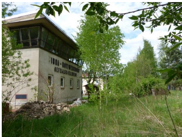
Foto 228: Pirna: Ehemaliges Befehlsstellwerk Pirna-Rottwerndorf
