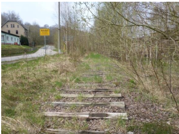
Foto 249: Mohsdorf: Schotterkörper und Schwellen sind noch sichtbar, begonnene Verbuschung
