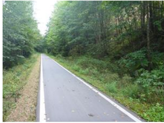
Foto 81: Verläuf des Radweges in Einschnittlage durch Wald - Vor-Kopf-Bauweise erforderlich
