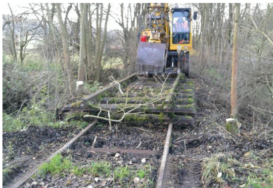
Foto 43: Entfernung von Gleise und Schwellen (Foto: http://forum.bauforum24.biz/forum/index.php?showtopic=44442 )
