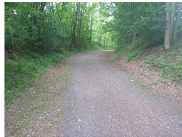
Foto 354: Wilsdruff, Herzogswalder Straße (B 173): Radweg in ungebundener Bauweise, in Einschnittlage
