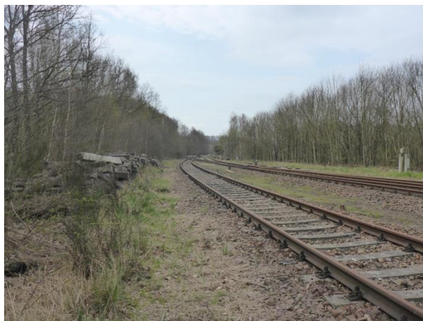
Foto 244: Wechselburg: Bahnkörper vollständig vorhanden, seitliche Ablagerungen von Betonschwellen
