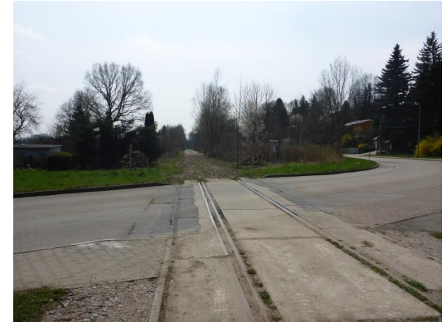
Foto 328: Chemnitz-Wittgensdorf: Schotterkörper bereits vorbereitet für Radwegebau
