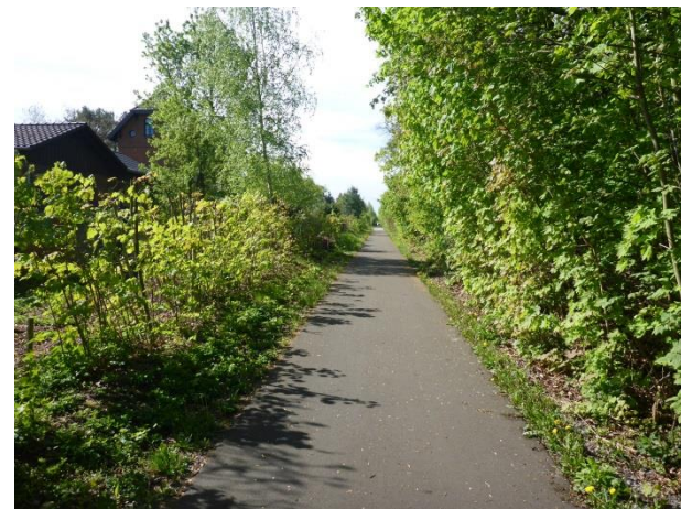
Foto 345: Seebenisch: Radweg in Asphaltbauweise umgesetzt
