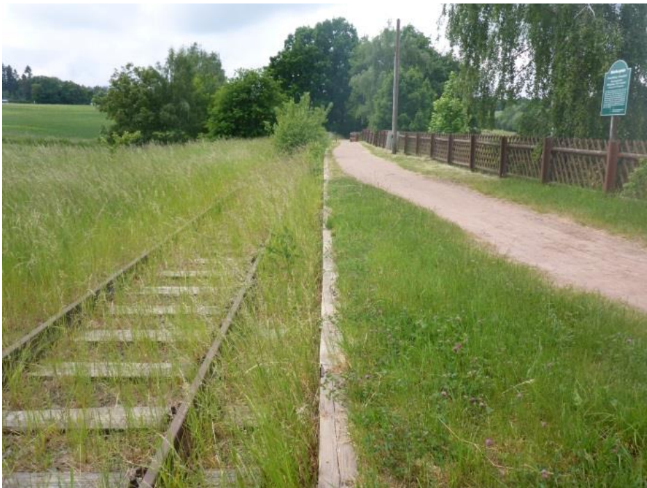
Foto 92: Wegeführung parallel zum Gleis – Erhalt des Gleisschotters als Reptilienhabitat (parallel geführter Radweg in ungebundener Bauweise umgesetzt)
