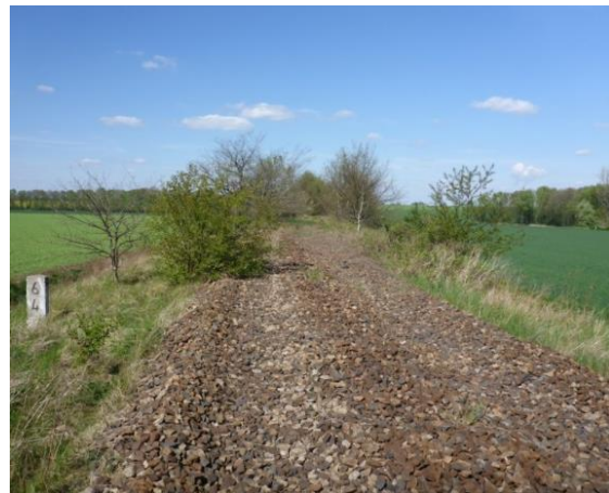
Foto 8: Teiltrückgebauter Bahnkörper ohne Gleise und Schwellen (Strecke 1998 stillgelegt)
