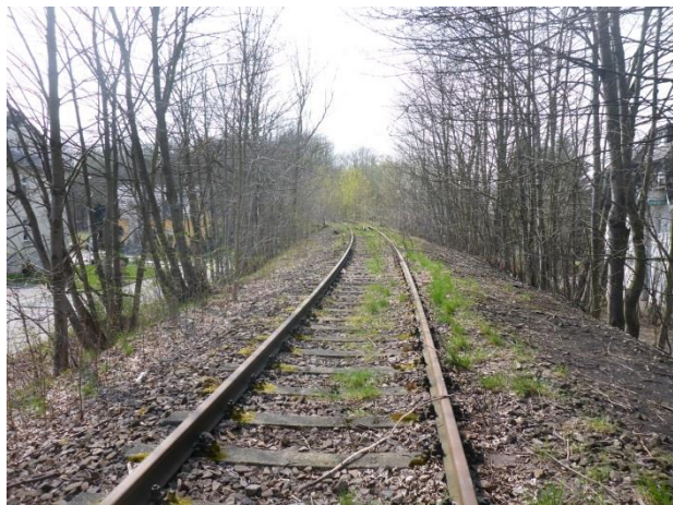
Foto 255: Chemnitz, Zur alten Gärtnerei: Bahnstrecke in Dammlage, noch weitgehend frei von Vegetation
