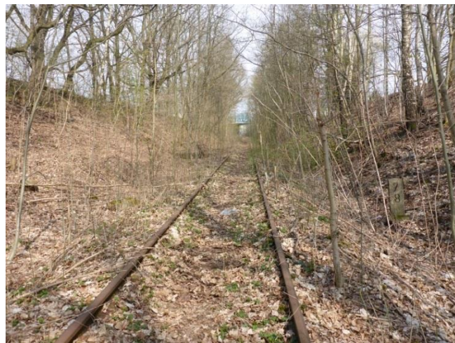
Foto 3: Bahnstrecke in Einschnittlage
