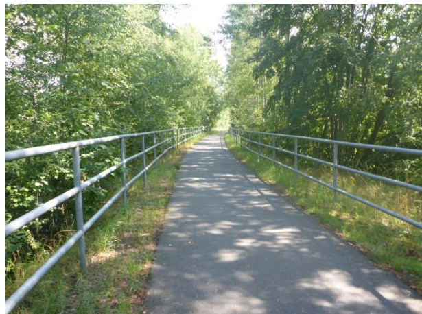
Foto 332: Aue, Brückenstraße: Asphaltierter Radweg in Dammlage
