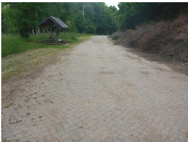
Foto 355: Wilsdruff, Herzogswalder Straße: Radweg in Pflasterbauweise
