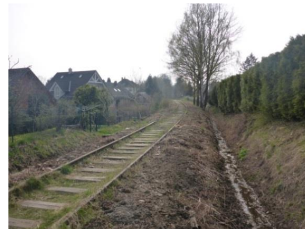
Foto 266: Wüstenbrand: Trasse freigehalten und seitlich ausgebagert (Bereich Illings Weg)
