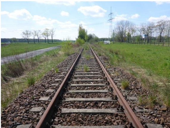
Foto 5: Bahnkörper vollständig vorhanden, wird betriebsfähig unterhalten (Strecke 1998 stillgelegt)
