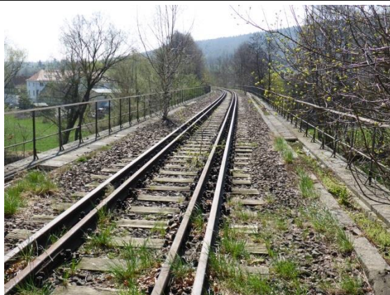
Foto 102: Bahnkörper inklusive Gleise und Schwellen mit einzelnen Grashorsten
