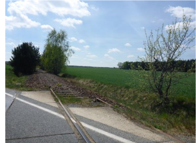
Foto 194: Zescha: Gleise noch vorhanden im Bereich der Querung mit der K 7284
