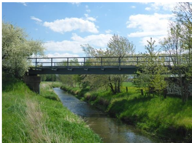
Foto 278: Mannschatz: Brückenbauwerk über die Döllnitz zwischen Mannschatz und Schmorkau
