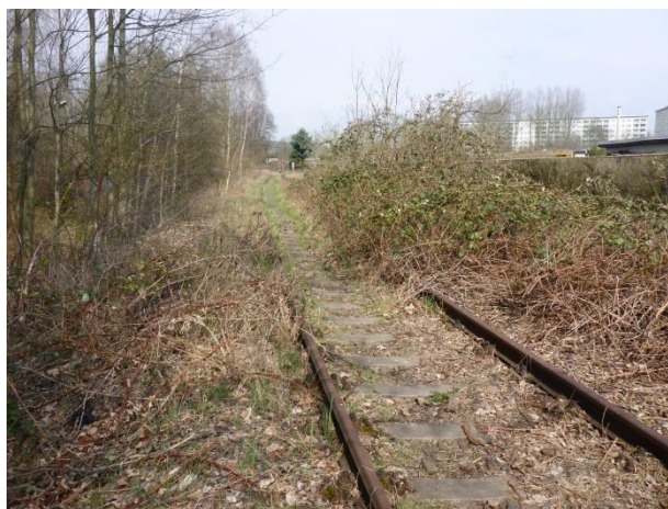
Foto 259: Chemnitz, Wittgensdorfer Straße: Vollständig erhaltener Bahnkörper mit seitlichem Aufwuchs von Brombeere
