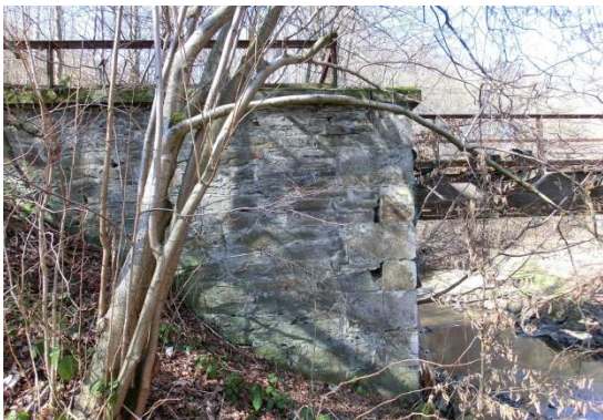
Foto 144: Widerlager mit offenen Fugen/potenziellen Fledermausquartieren (Foto: C. Schmidt)
