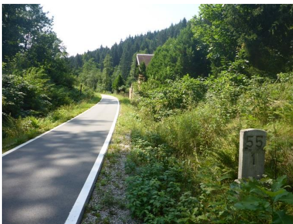
Foto 336: Bockau, Auer Talstraße: Hektometerstein an umgesetztem Radweg
