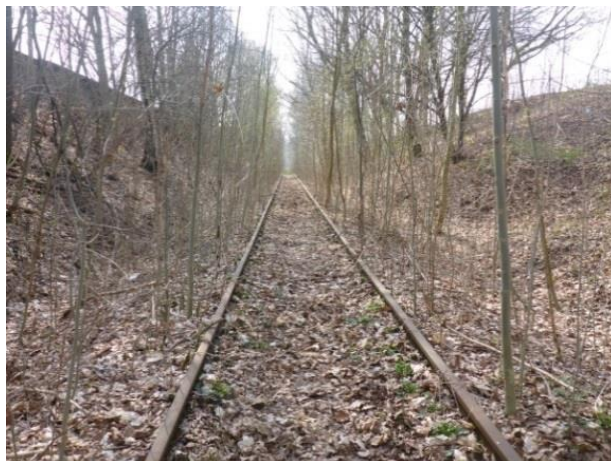
Foto 262: Chemnitz: Einschnittlage im Bereich Limbacher Straße
