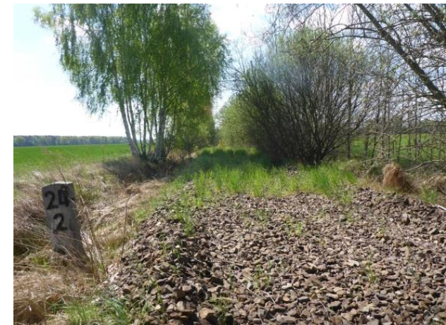
Foto 191: Wartha: Schotterkörper und Hektometerstein (südlich der Querung mit der B 96)
