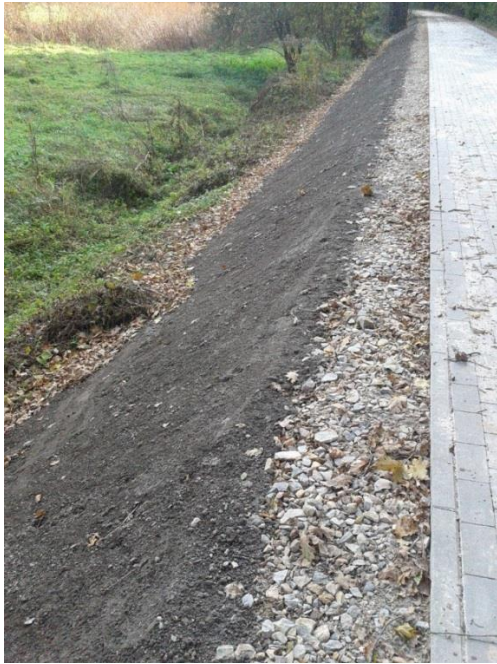
Foto 157: Substratauftrag im Böschungsbereich in geeigneten Abschnitten
