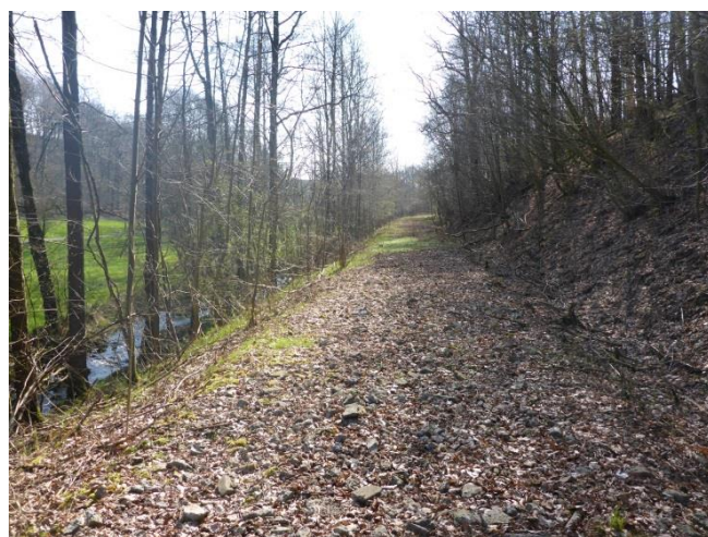
Foto 4: Bahnstrecke in Hanglage/Anschnittlage
