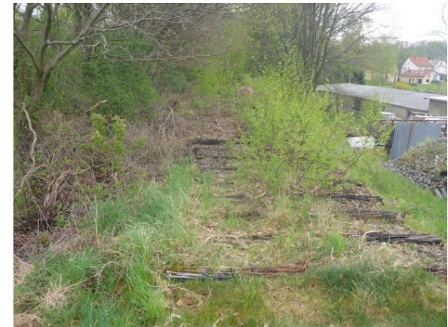
Foto 203: Wiesa: Birkenaufwuchs und ruderales Grasflur zwischen den Holzschwellen
