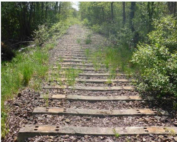
Foto 7: Bahnkörper teiltrückgebaut, Betonschwellen noch vorhanden (Strecke 1952 stillgelegt)
